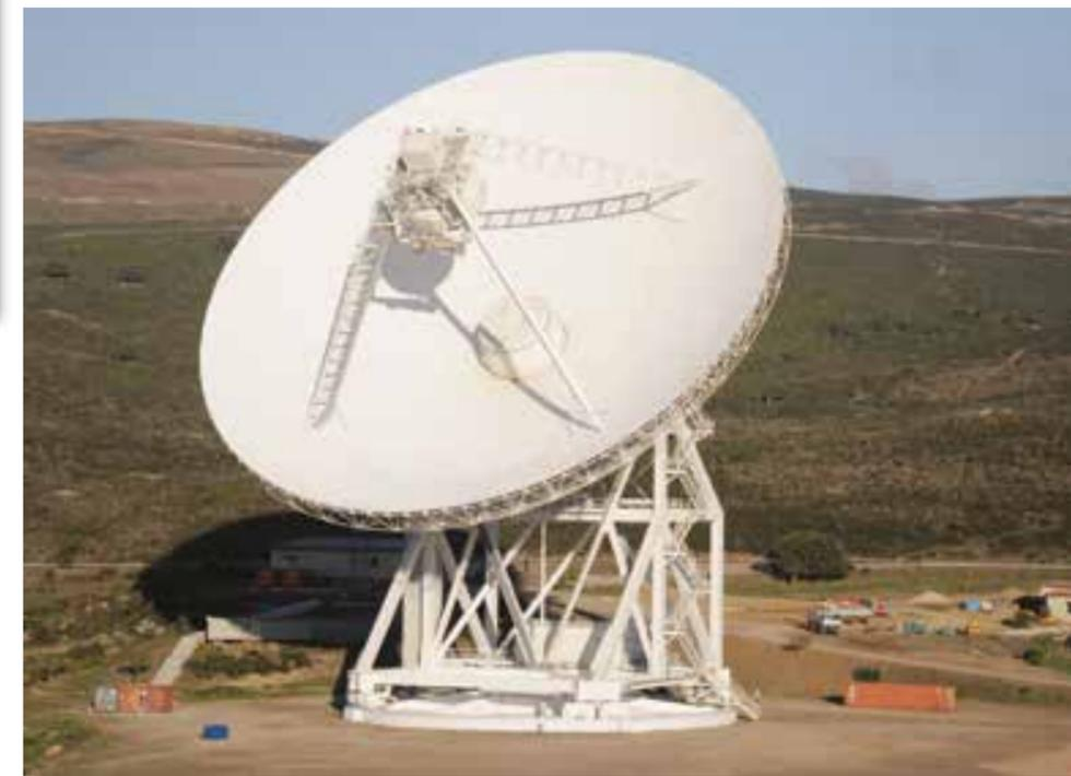
diotelescopio e può essere usata anche per misurare i movimenti della terra (geodesia).
